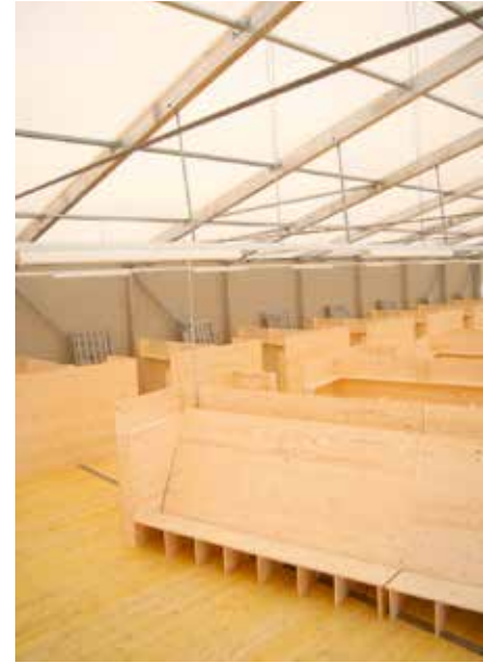
Aus Brandschutzgründen wurden die Trennwände auf eine Höhe von 1,60 Meter reduziert. Fotos: Jan Schabert
